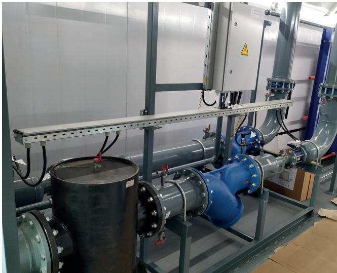
ИТП **Сететерм Макси** мощностью более 6,5 МВт в контейнере полностью автоматизирован и не требует присутствия обслуживающего персонала, включает в себя узел ввода и учета теплопотребления с грязевиком, фильтрами и тепловычислителем с датчиками и электромагнитными расходомерами.
