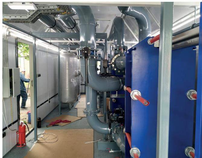
При этом команда Сететерм смогла обеспечить легкий доступ для обслуживания и ремонта ко всем компонентам ИТП. Даже разобрать теплообменники M15 для механической очистки или замены пластин и уплотнений можно не сдвигая с места раму с нажимной плитой и пристыкованными трубопроводами.
